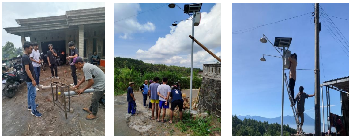
Gambar 1 Praktek Instalasi PJU Tenaga Surya (sumber : hasil pengabdian)
