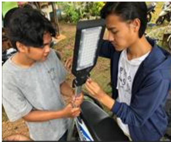
**Gambar 2. Proses perakitan lampu dan tiang lampu penerangan jalan umum.**
