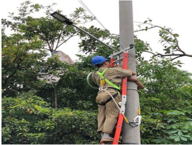
**Gambar 3. Pemasangan penerangan jalan umum.**
